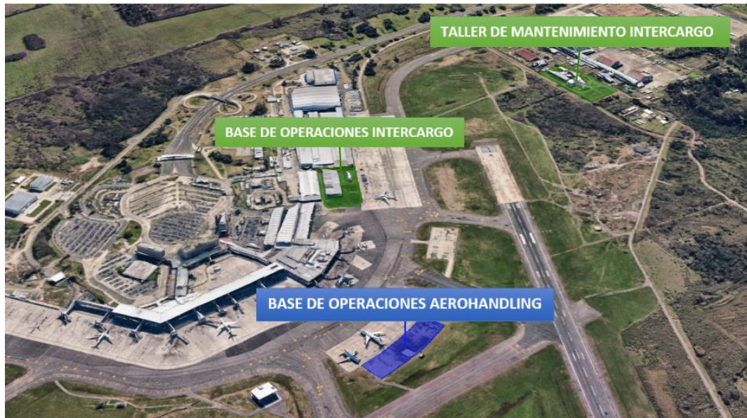
Figura 42 - Base de operaciones Aerohandling e Intercargo
