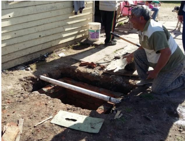
**Imagen 3.** construcción de la cámara séptica.
