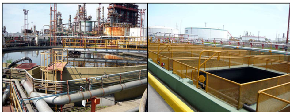
Figura III. 2. Piletas o separadores API. Instalaciones donde se separan los aceites y sólidos en suspensión de las aguas residuales (efluentes) provenientes de la refinación del crudo de petróleo.
