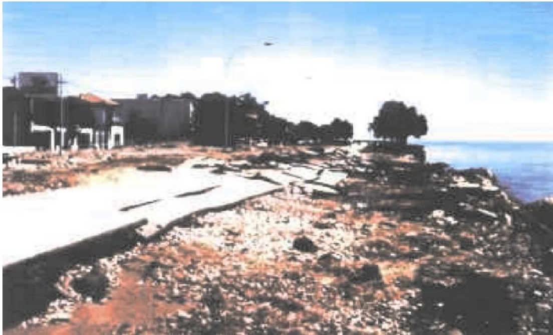
Figura 5.11: Rotura del murallón de la costanera de Punta Lara
