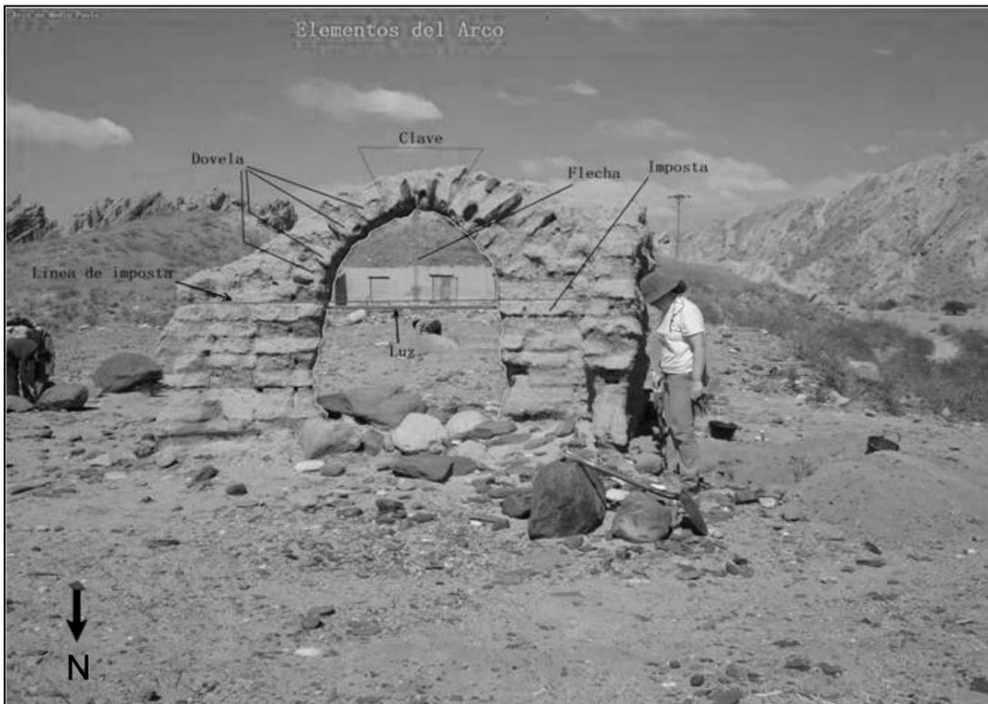
Fig. 5.24: Componentes del arco (Foto de la autora y diagrama de F. Guerrero)
