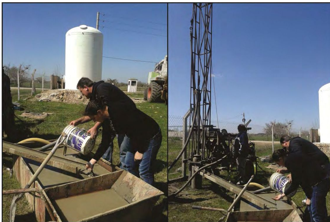
Figura 2.2: Pozo efectuado con una perforadora a rotación con inyección de agua en el sector de planicie costera.
