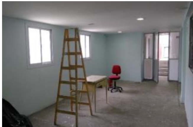
Figura 17. Adecuación edilicia con pintura acorde para cámaras IR Fuente: elaboración propia
