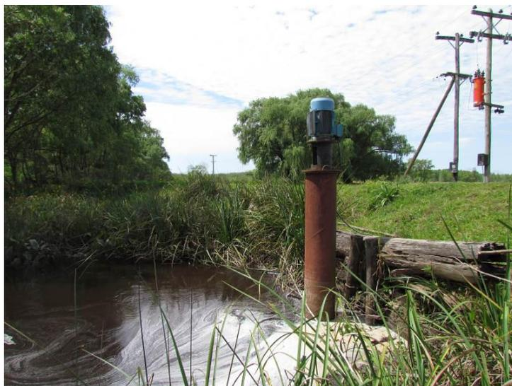
**Figura 60.** Bomba y polder reguladora del caudal en la entrada del río al canal bomba 2.
