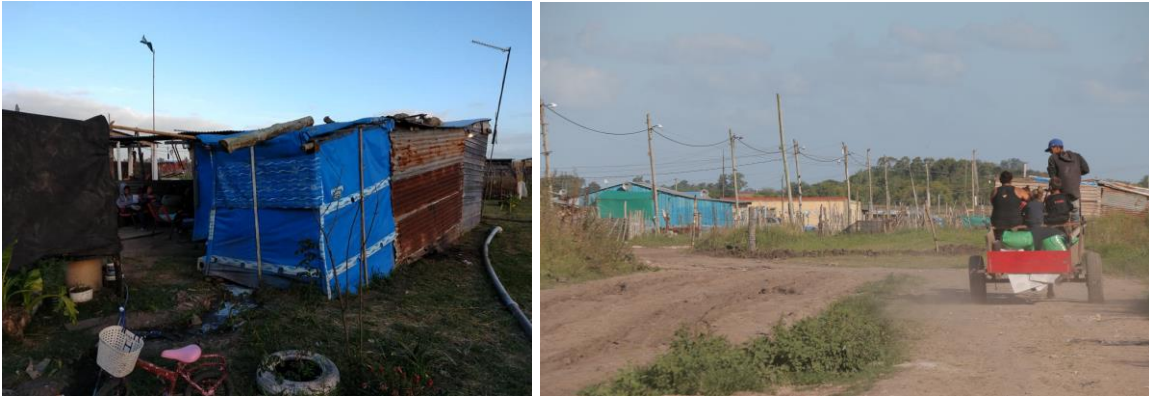
Fotos 54 y 55. Viviendas precarias asentadas en Barrio Evita (Foto izquierda, Horacio Bozzano; derecha, Tomás Canevari).
