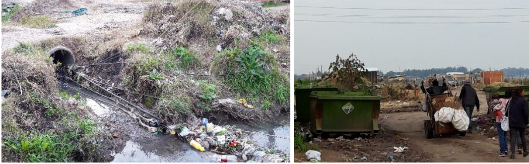
Fotos 14 y 15. Conexiones precarias y basurales (Fotos Tomás Canevari).
