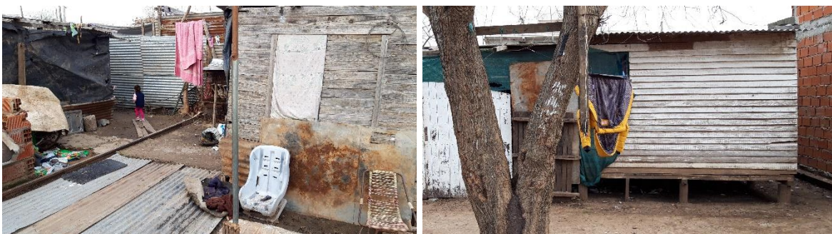
Fotos 18 y 19. Construcción precaria de viviendas y construcción sobre pilotes post inundación de 2013 (Fotos Tomás Canevari).
