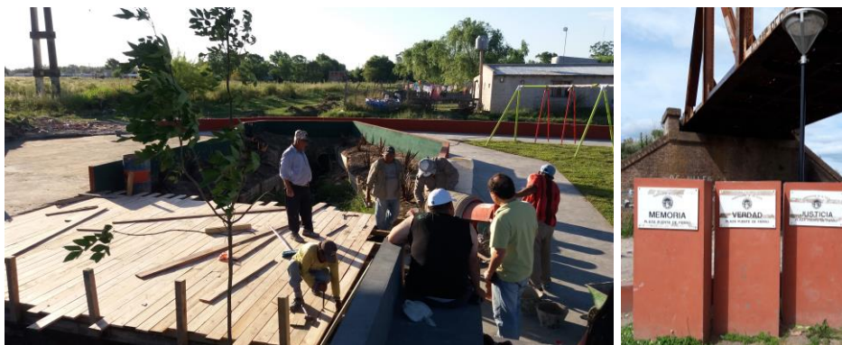
Fotos 59 y 60. Cooperativistas trabajan en la construcción de la plaza en el año 2017. A la derecha, las placas de Memoria, Verdad y Justicia debajo del puente (Fotos Tomás Canevari).
