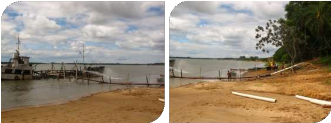
FOTOS 28 Y 29 - REFULADO EN LA ZONA DE COSTA EN CONTACTO CON EL RÍO (FOTOS PROPIAS).
