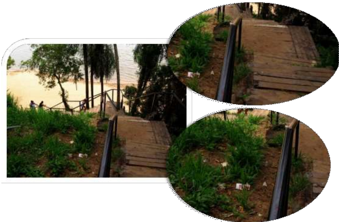
FOTO 17: ESTRUCTURA DE ACCESO AL BALNEARIO; FOTO 18: DETALLE DEL ESTADO DE LAS ESCALERAS Y RAMPAS, FOTO 19: SENDAS CON SUELO DESNUDO Y COMPACTADO. (FOTOS PROPIAS).
