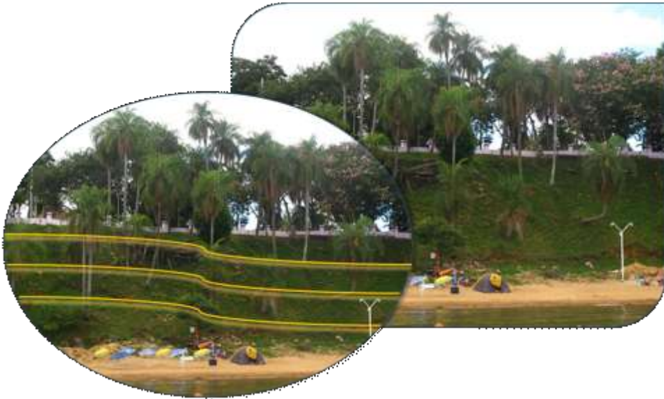
FOTOS 51 Y 52 – PLAYA DE LAS PALMERAS, PROPUESTA DE CONSOLIDACIÓN MEDIANTE ATERRAZAMIENTO (FOTOS Y ESQUEMAS DE ELABORACIÓN PROPIOS).
