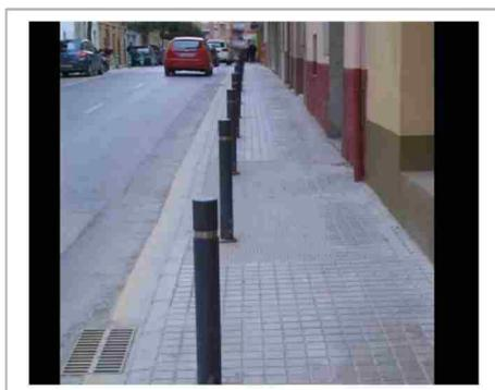
Los bolardos son elementos de contención que ponen un límite entre la circulación vehicular y la vereda. Nótese que guardan una distancia al cordón que permite disponer el alcantarillado
