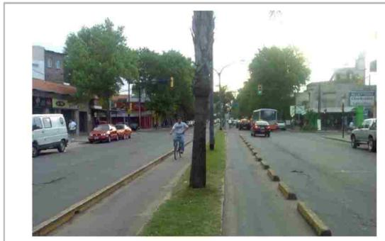
Ejemplo carril de bicicleta adyacente a rambla central, demarcado con elementos premoldeados de hormigón con cantos redondeados.
