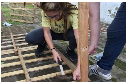
Figura 3 Panelizado realizando las uniones por clavado
