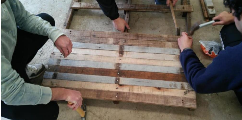
Figura 5 panelizado con tablillas
