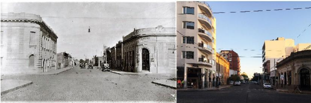
Figura 2.4. Imagen del edificio original de General Paz y Moreno, a la izquierda; fotografía del edificio actual, a la derecha. Fuente: elaboración personal con fotografía del archivo de Adolfo Hipólito Santa María.
