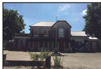
Estación "El Provincial"
