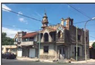
La Obra Zichieri
