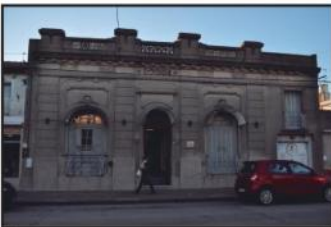
Vivienda Unifamiliar (24) Ubicación: 9 de julio 3055 Año: 1927
