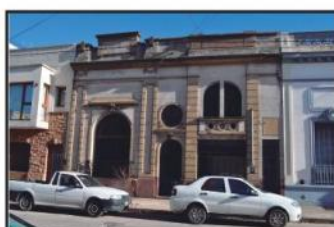
Vivienda Unifamiliar (22) Ubicación:9 de Julio 2443 Año:¿?
