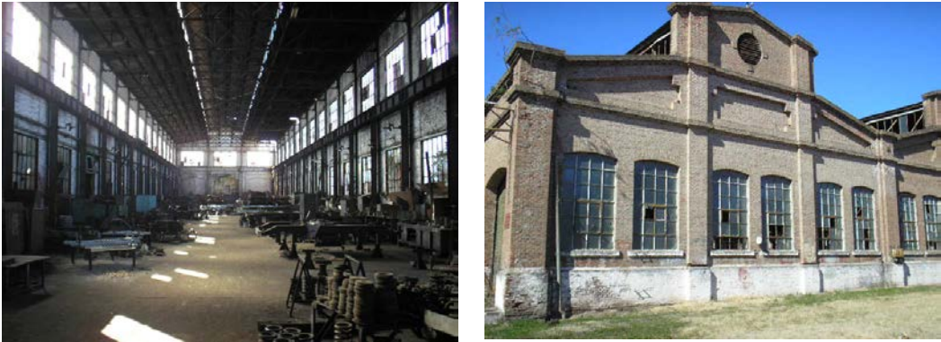
Figura 8. Cooperativas de trabajo en edificios de los ex-talleres ferroviarios (Junín).
