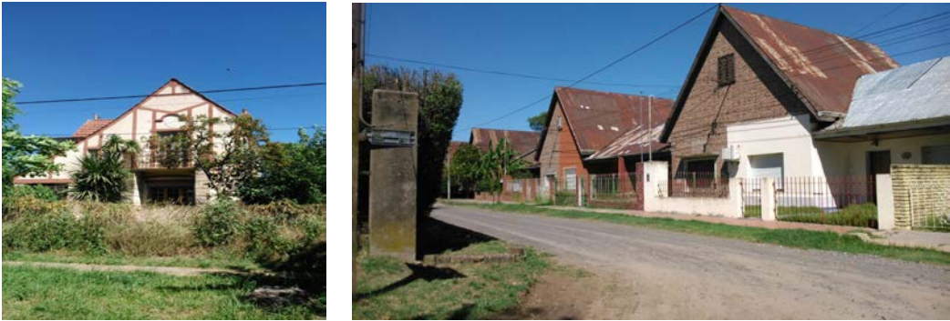
Figura 6. Colonia ferroviaria: Viviendas de personal jerárquico y viviendas de operarios.
