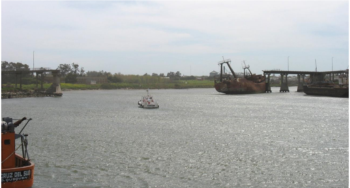
Figura 6. Vista de los restos del Puente carretero Ignacio Ezcurra. A la izquierda se observa el barco Ribera Gallega parcialmente hundido contra uno de los pilares del antiguo puente (foto enero de 2006).
