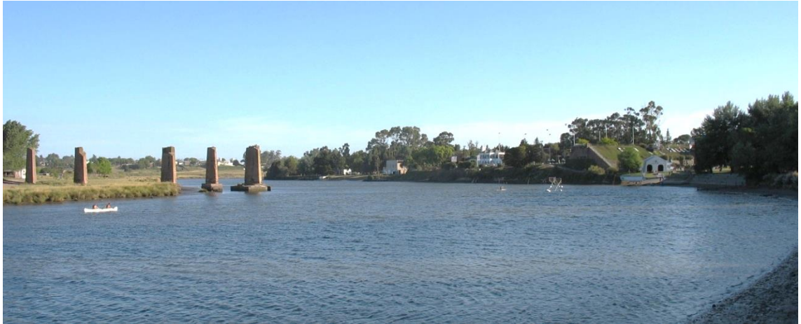
Figura 5. Pilotes y restos del puente ferroviario que unía ambas márgenes del río Quequén que se destruyó en el año 1980. (Foto enero 2007).
