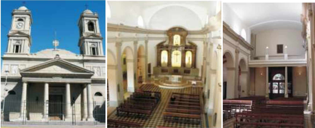
Figura 12. Fachada de la parroquia Santa Rosa de Lima. Figuras 13 y 14. Vistas interiores de la nave principal. Fuente: Catálogo de Bienes Patrimoniales del partido de Bragado.
