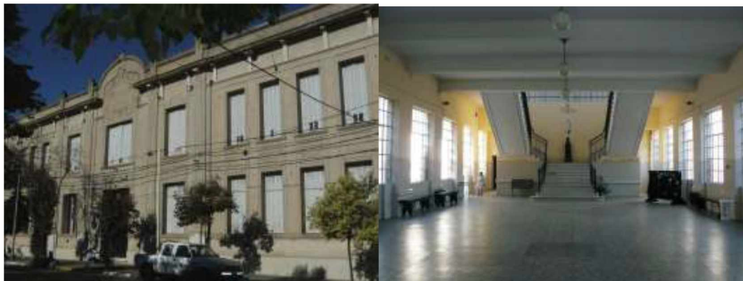
Figura 2. Fachada de la Escuela N°1 de Bragado. Figura 3. Patio interno (SUM) en planta baja. Fuente: Catálogo de Bienes Patrimoniales del partido de Bragado.
