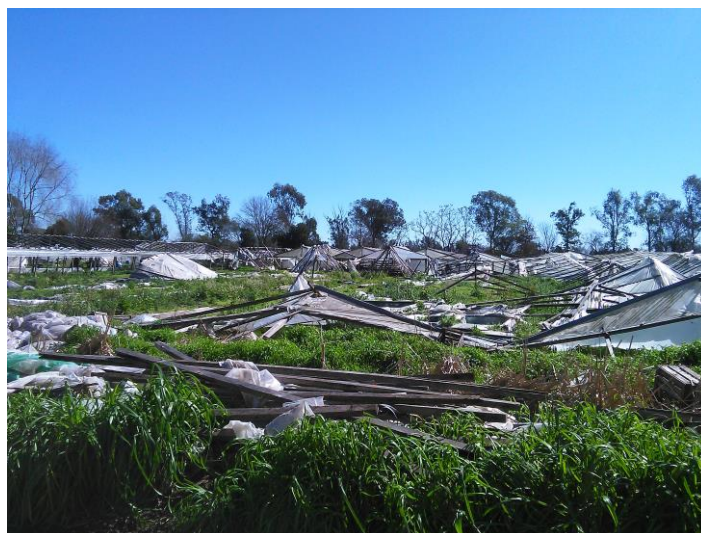
Figura 1. Efectos de temporal sobre infraestructura de invernáculos, zona El Peligro (febrero, 2017)
