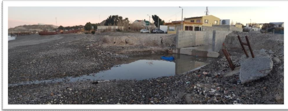
Figura 9: desagüe de efluentes cloacales al mar.
