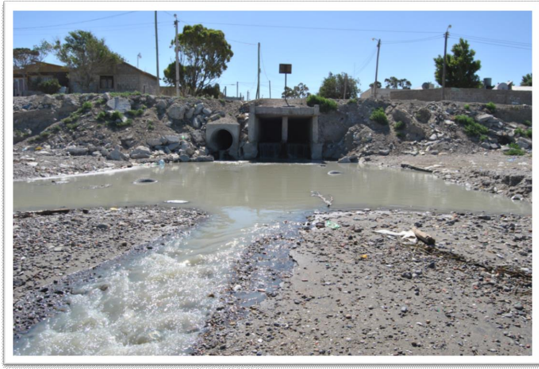
Figura 20: efluente de red cloacal troncal sobre la playa del Barrio Stella Maris.
