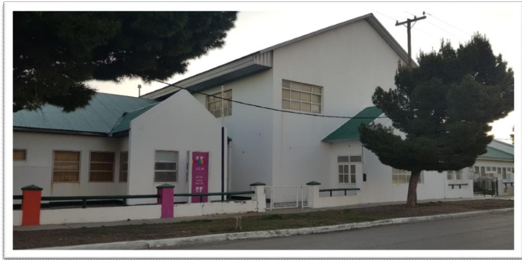
Figura 26: Escuela Provincial n° 104 en el Barrio Caleta Córdoba.
