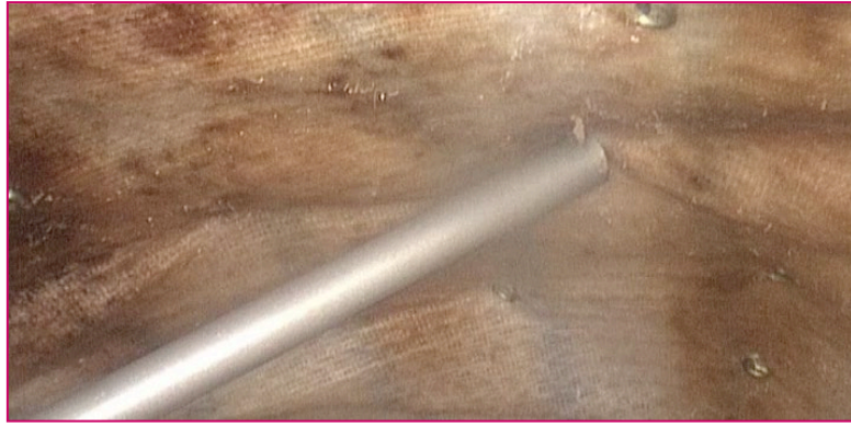
FIGURA 9. COLOCACIÓN DE MALLA DOBLE CAPA Y FIJACIÓN POR DEBAJO DEL DEFECTO
