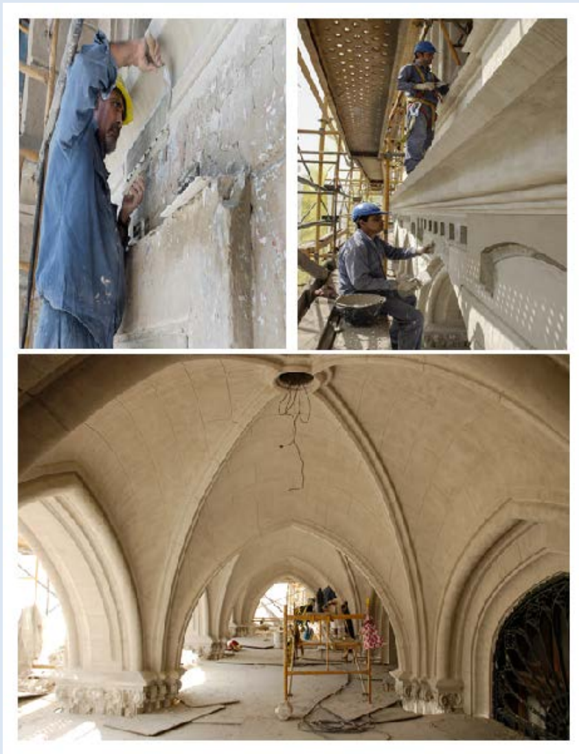
Fig. N° 44, 45 y 46.- Imágenes de los trabajos de intervención edilicia en revoques y cúpula de acceso al edificio de Paseo Colón 922. (Fotografías tomadas por la empresa CONSULPER S.A.)- Año 2012
