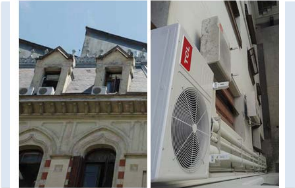
Fig. Nº 53 y 54.- Imágenes fachada posterior (cara este) Edificio Paseo Colon Nº 982 previo a las obras de readecuación y fachada interna una vez intervenida. (Autoría: Marta Casabene fotógrafa del Programa de Patrimonio Cultural del Ministerio de Agroindustria).
