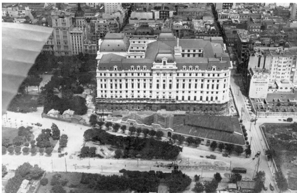
Fig N° 2.- Fotografía aérea fachada este Palacio del Correo (en blanco y negro). Autor desconocido 6
