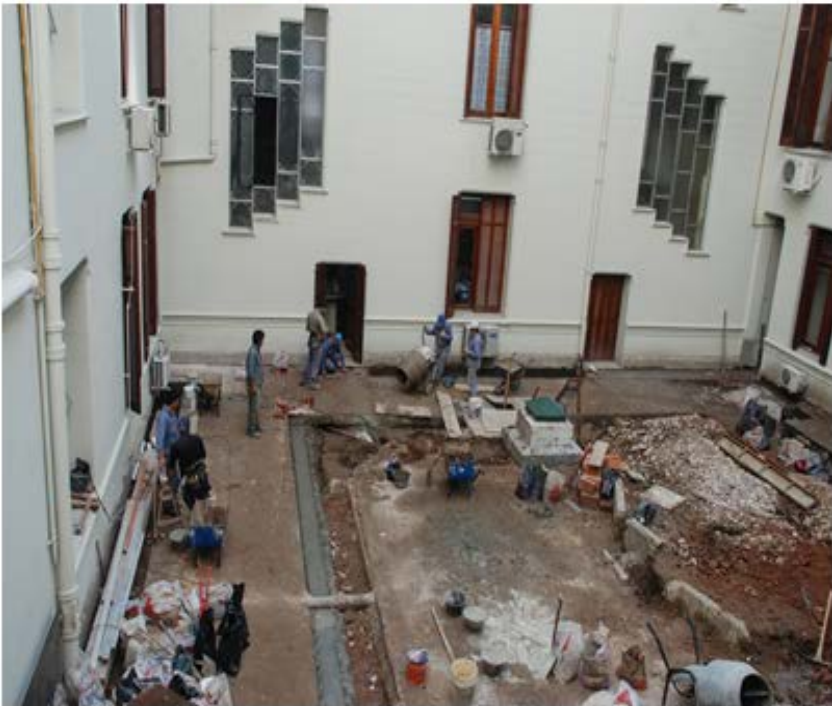
Fig. N° 55 y 56.- Imágenes del estado de patio interno del Edificio de Paseo Colón N° 982 antes de la intervención y durante la ejecución de los trabajos. (Autoría: arquitecto Marcelo Magadán- Año 2013).
