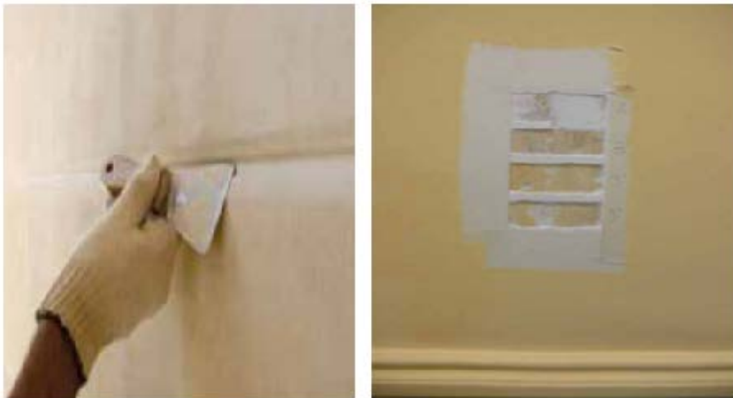
Fig. N°42 y 43.- Aplicación del nuevo Símil piedra y cateos de color en muros interiores
