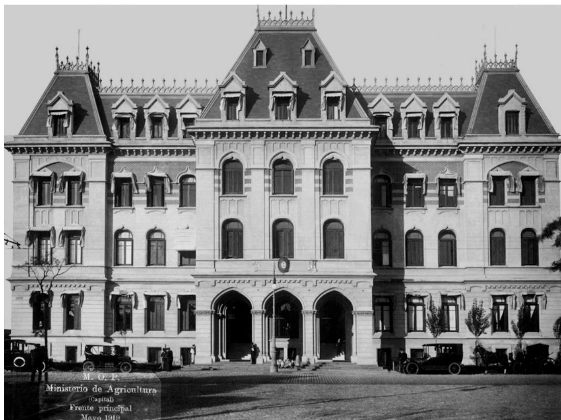
Fig. Nº 29 y 30.- IMÁGENES EDIFICIO PASEO COLÓN 982
