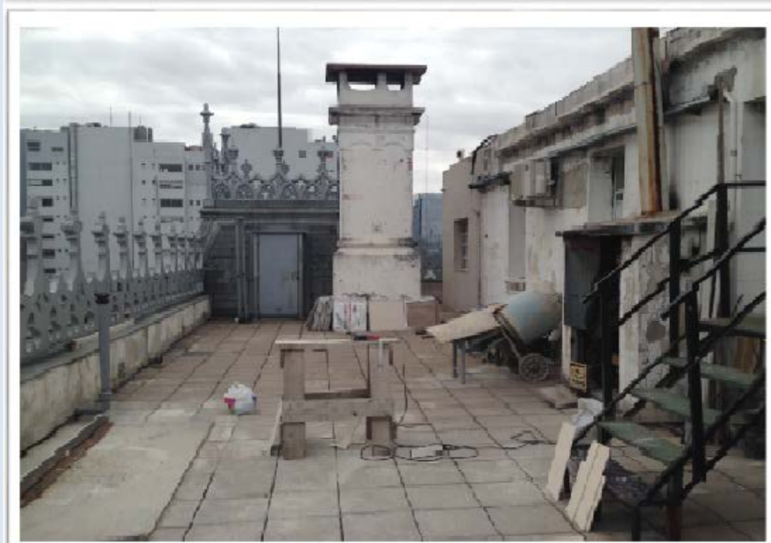
Fig. N° 75 y N° 76.- Fotografía Antigua Ampliación sector NE del 4to piso del edificio de Paseo Colon N° 982 (Circa 1936, digitalizado por el CeDIAP) y actual del mismo sector (Autoría Propia).
