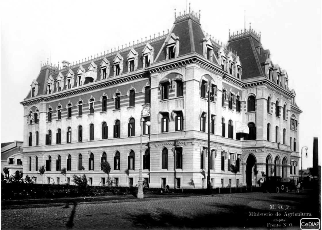
Fig. N° 27 y 28.- IMÁGENES EDIFICIO PASEO COLÓN 982
