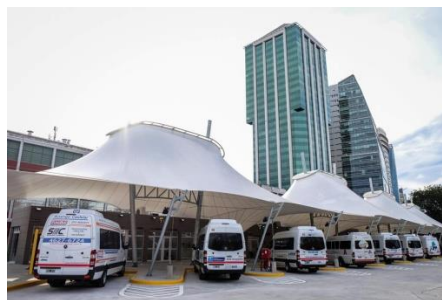
Figura 2. Detalle de la geometría de la cubierta flexible instalada. Cortesía de Consultora WAGG (derechos reservados).
