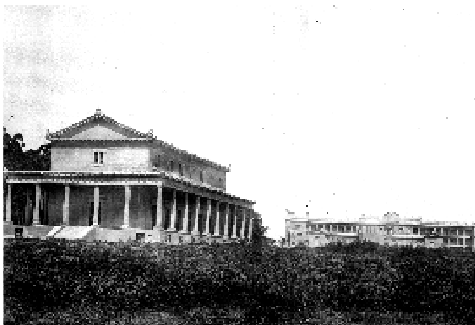
Vista general del campus de la UNLP que permite reconocer el eje principal y la secuencia de edificios que lo conforman: Colegio Nacional, Instituto de Física y Gimnasio.
