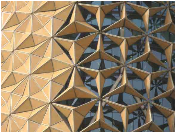
Fig 5: Piezas adaptativas para optimizar el rendimiento de la Torre Al Bahar en Abu Dhabi del año 2009-2012 diseñado por Abdulmajid Karanouh Associate Architect
