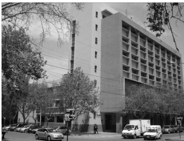
Figura 1: Edificio Central de la Universidad Nacional de San Juan (ECU)
