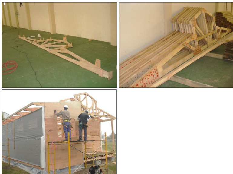
Figura 8. Armado cercha. Figura 9. Cerchas terminadas. Figura 10. Cerchas colocadas.
