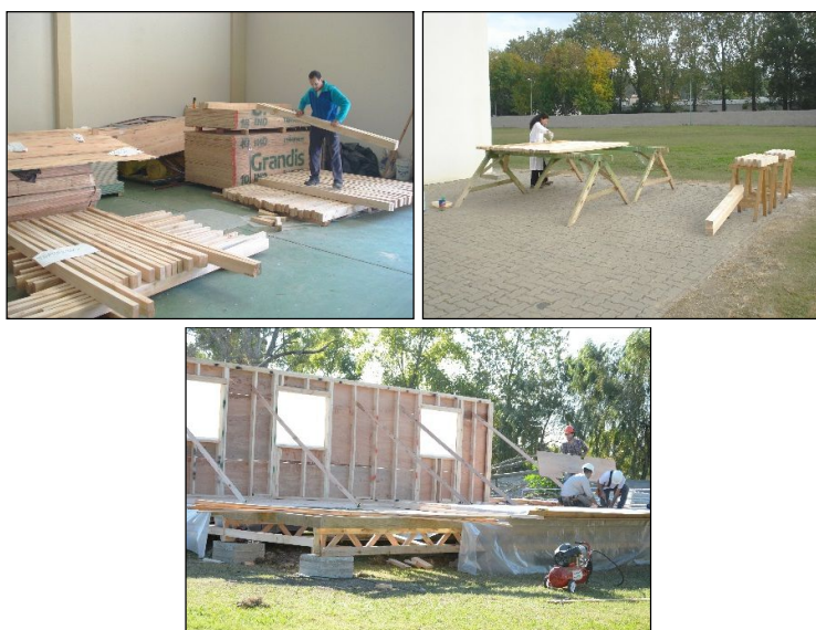
Figura 5. Vigas predimensionadas. Figura 6. Protección. Figura 7. Muro en obra.
