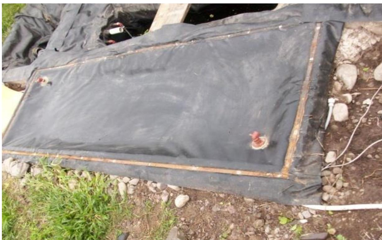
Figura 6.19. Colector solar.
