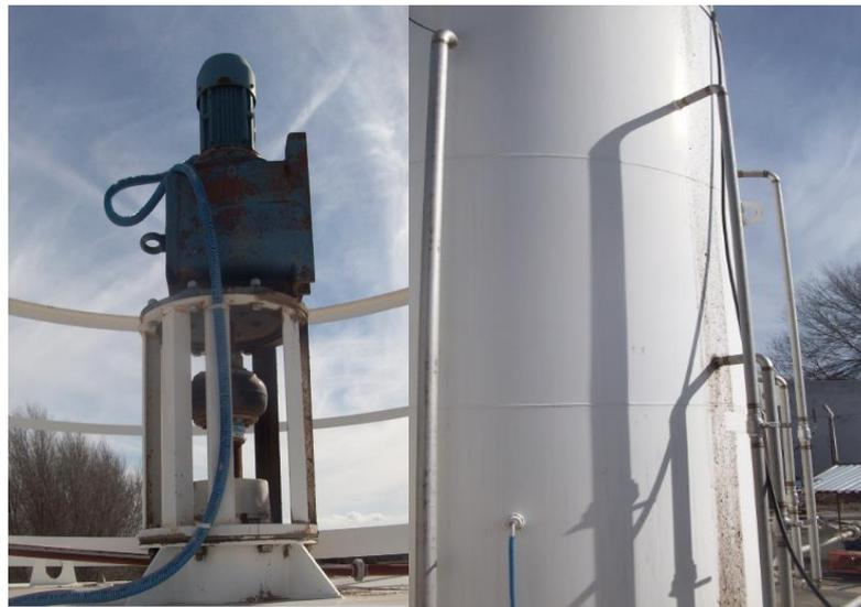
Figura 1.7. Motor para el mezclado y ductos de recirculación.
