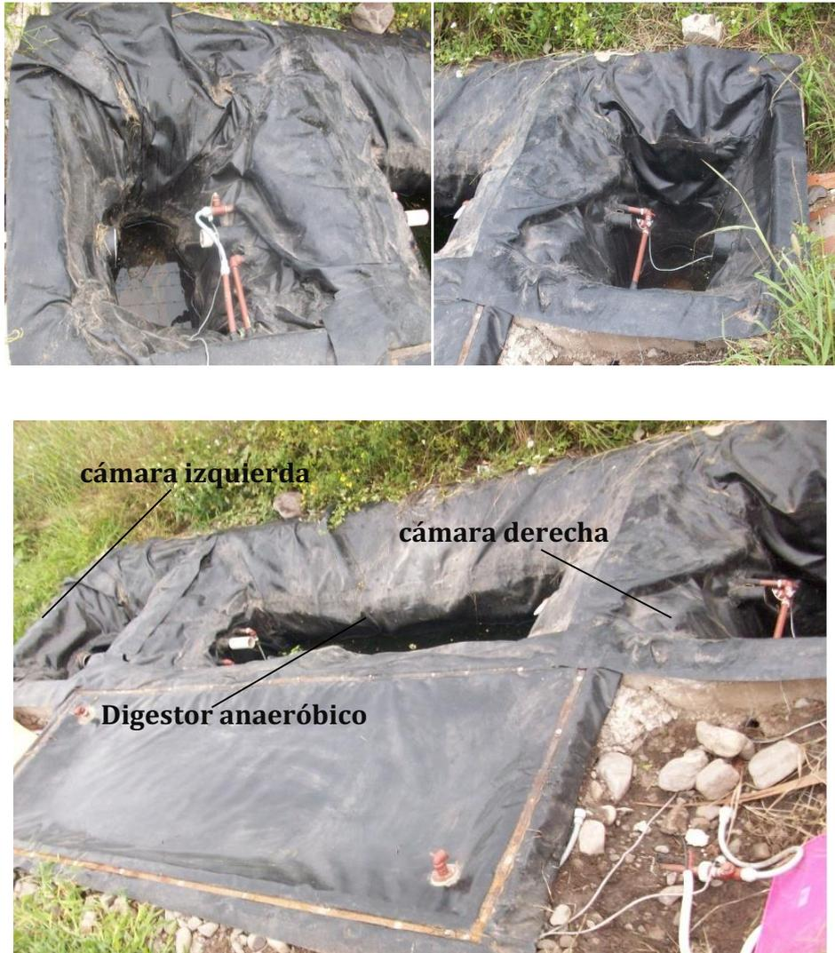
Figura 6.15. Cámaras laterales y el digestor completo- Caso C.
