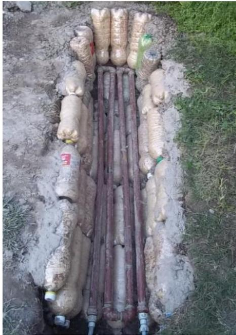
Figura 6.5. Vista de la fosa cubierta con las botellas y tubos del intercambiador.
