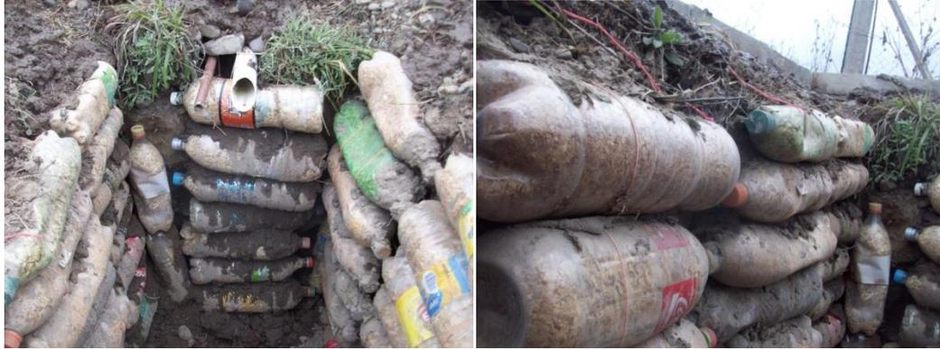
Figura 6.13. Distintas etapas de la colocación de las botellas.
