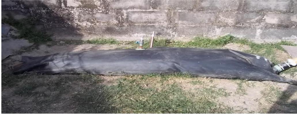
Figura 6.2. Vista del digestor tubular instalado en el terreno.
