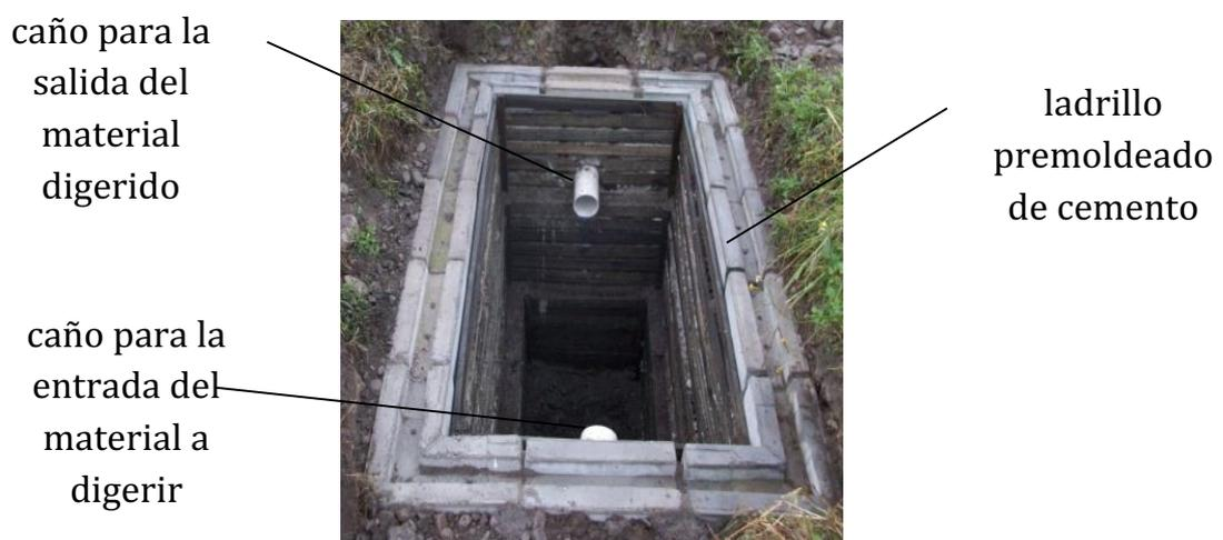
Figura 6.7. Construcción del digestor.
