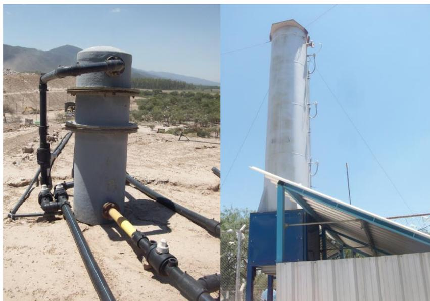
Figura 1.9. Vista del contenedor con viruta de hierro (izquierda) y quemador (derecha).
