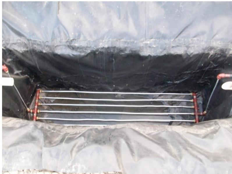
(b) vista del intercambiador de calor instalado en el digester.
