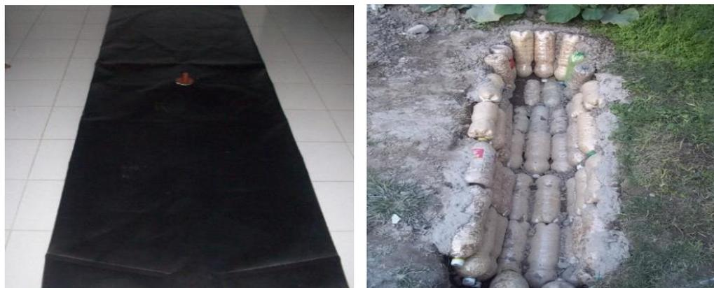
Figura 6.1. Vista del digester desplegado sobre el suelo (izquierda), aislación cubriendo la fosa (derecha).
