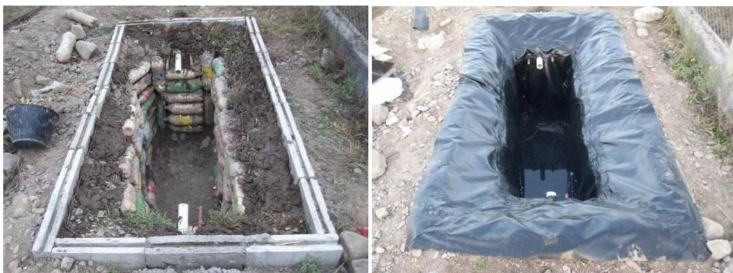
Figura 6.14. Distintas etapas de la construcción del digester anaeróbico enterrado con mejoras, caso C.
