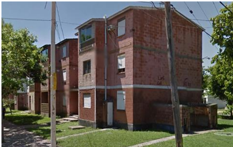
Figura 29. Vista actual de vivienda multifamiliar, ubicada en Muntaabsky 780, perteneciente al Barrio Obrero, complejo habitacional ubicado en el Barrio San Martín
