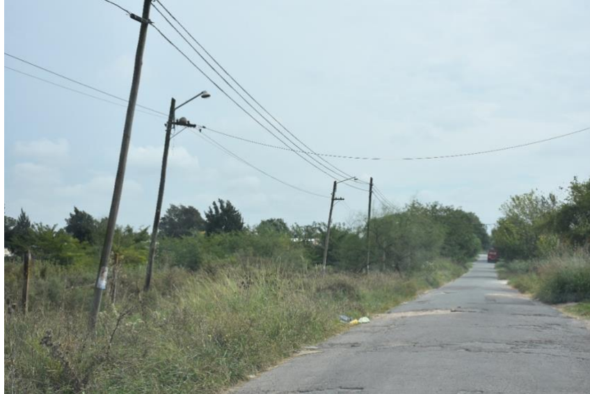
Imagen 9.: Vista de calle 157 e/60 y 58. Autora: Dra. Victoria Goenaga . 2019.
