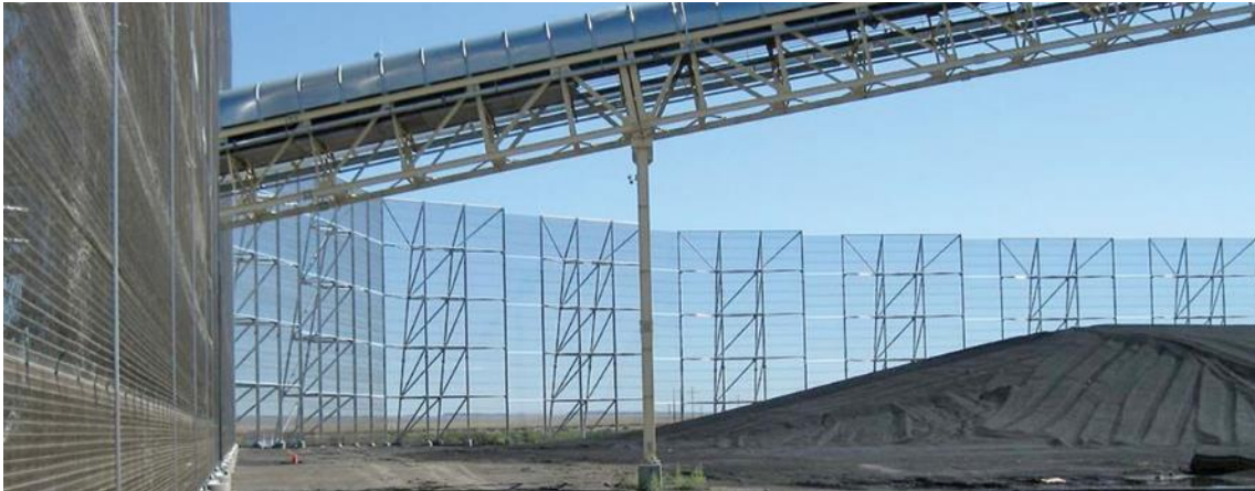
Figura 3. Mallas cortavientos sintéticas para protección de infraestructura industrial en minería.
