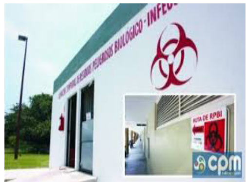
Figura 6. Aquí se muestran las dimensiones, ubicación, orientación y señalización de almacén temporal que reúne los requisitos de acuerdo a la NOM 087.
