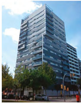
Cámara cerrada. Ventilación por juntas abiertas
