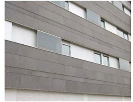
Cámara cerrada. Ventilación por juntas abiertas
