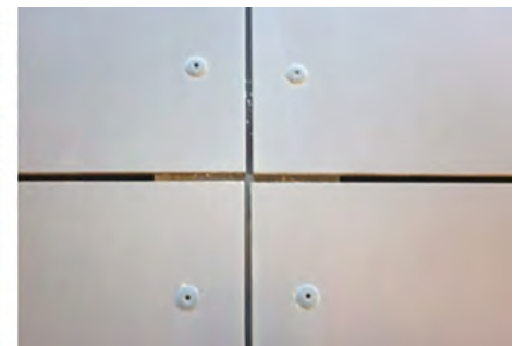
Cámara cerrada. Ventilación por juntas abiertas
