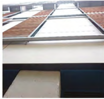
Cámara cerrada. Ventilación por juntas abiertas
