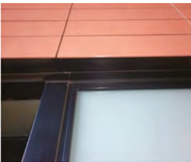
Cámara cerrada. Ventilación por juntas abiertas
