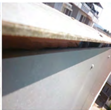
Cámara abierta. Ventilación por apertura inferior y superior
