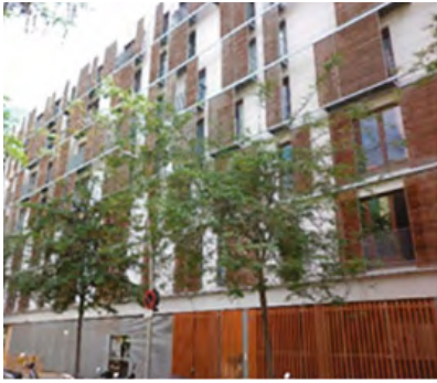
Cámara cerrada. Ventilación por juntas abiertas
