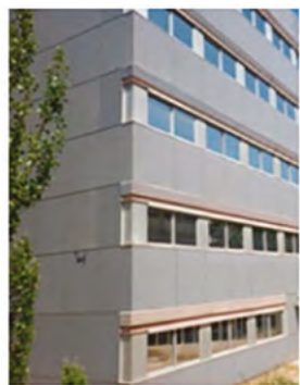
Cámara abierta. Ventilación por apertura inferior y superior
