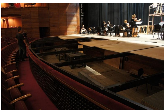
Fig. 9. Fotografía del armado del foso en la Sala Ginastera del Teatro Argentino.
