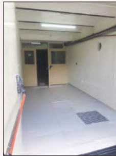
Pintura de los pasillos de acceso a los sanitarios.
