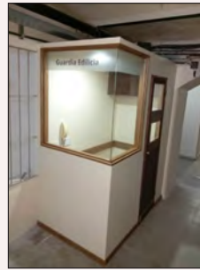
Refacción del sector de ingreso por la fachada posterior.
