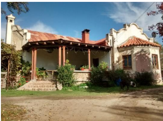
Figura 5: Casa Platense -antigua casa patronal Flia Alurralde- (San José) Fuente: Paisajes Culturales de Tupungato 2da. Etapa
