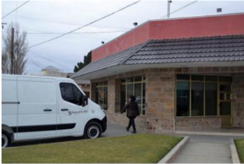
Figura 3. Casa velatoria Ramps “Cochería del Sur”
