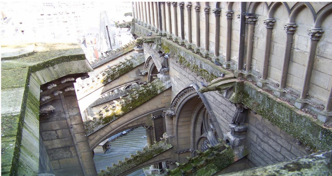
Figura 1.1. Biodeterioro en la fachada de la Catedral de Reims, Francia. Tomado de Eyssautier-Chuine et al., 2021.
