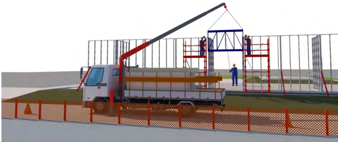
Gráfico N° II.24: Procedimiento de montaje de piezas especiales.
