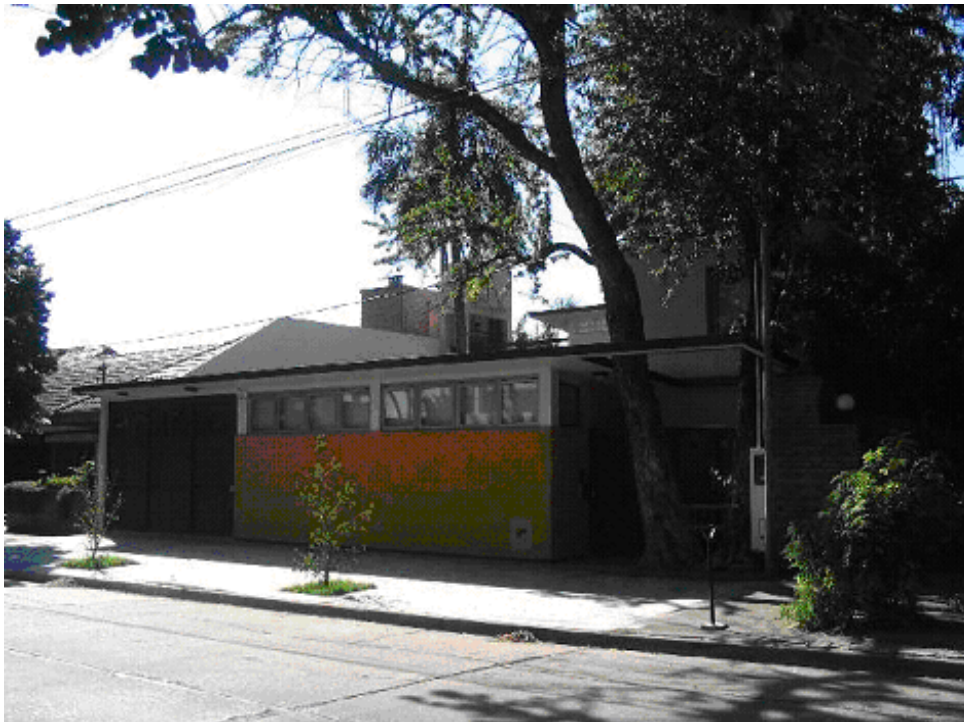
Figura 6-13: Vista exterior de la casa terminada. (noroeste)
