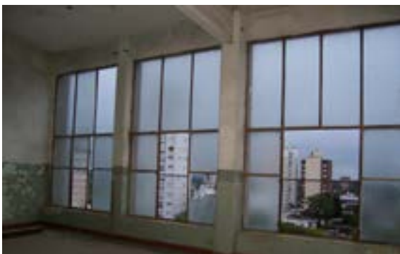
Imagen 6. Vista actual desde el interior. Se visualizan elementos estructurales (vigas y columnas) y el muro vidriado del frente del edificio.
