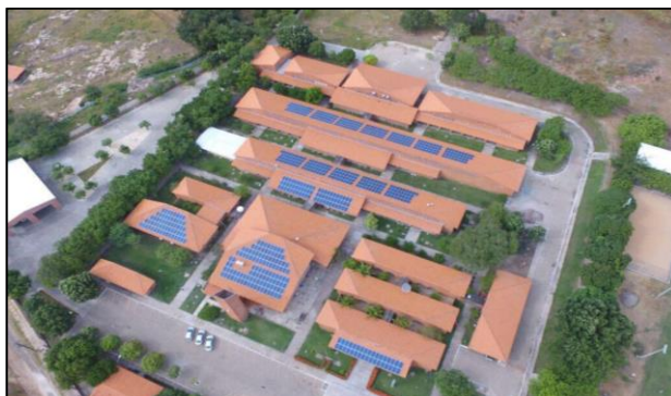
Figura 1: Disposição dos módulos fotovoltaicos no telhado do campus Floriano
