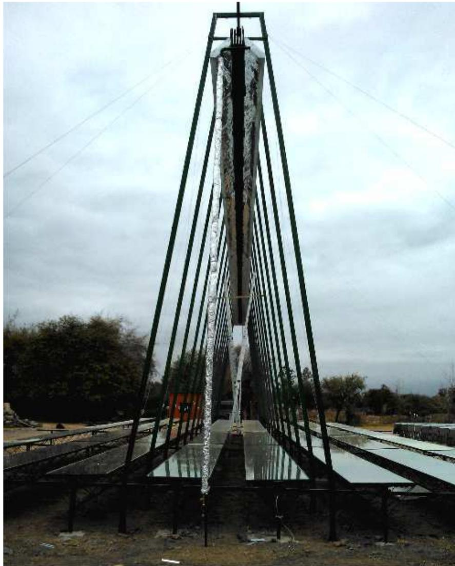
Figura 3. - Se aprecian en detalle los espejos y sus soportes con la casilla de control al fondo
