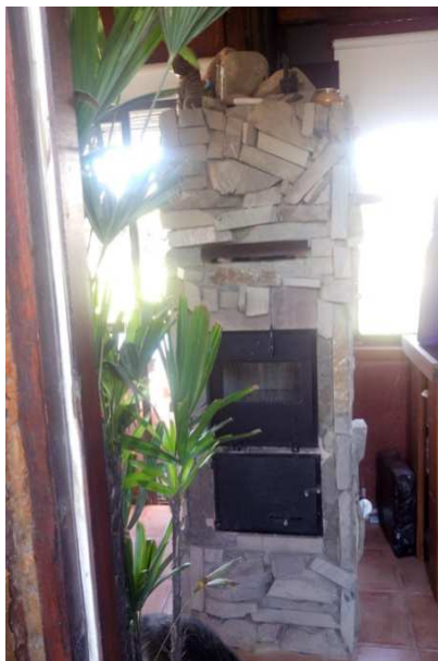
Figura 1: Izquierda: Estufa rusa ensayada. Derecha: vista anterior y corte donde se observa el sentido de circulación del aire y el intercambiador de calor de flujo cruzado incorporado como mejora de diseño.
