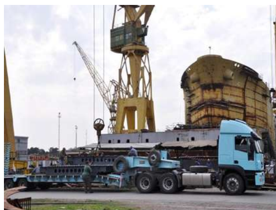
Estiba de un puente realizado para provincia de Buenos Aires
