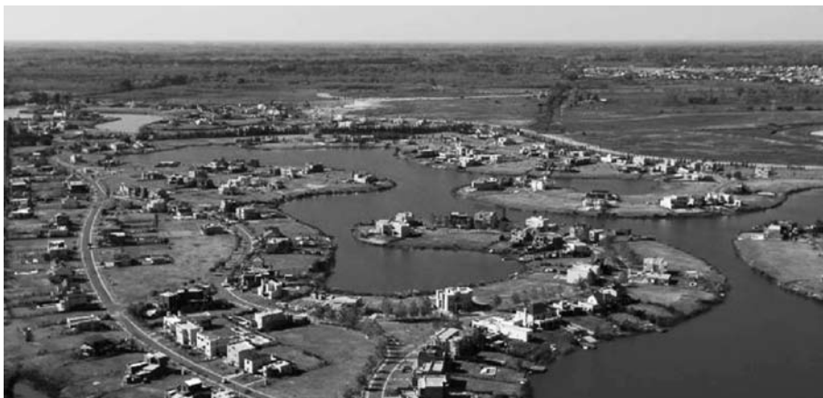
Figura 2: Vista aérea barrio Santa Catalina del Complejo Villanueva. Partido de Tigre
