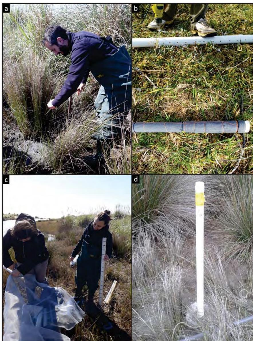
**Figura 2.3.** Fotos tomadas en campo durante la construcción de los pozos de exploración someros: a- Corresponde al barreno manual; b- Caño de PVC ranurado; c- Colocación de malla plástica en el caño de PVC ranurado; d- Freatímetro terminado.
