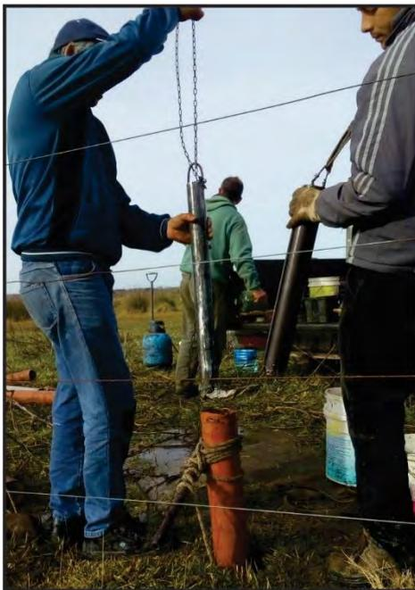
**Figura 2.4.** Foto tomada en campo durante la construcción de los freáticos construidos a profundidades máximas de 5,3 m.
