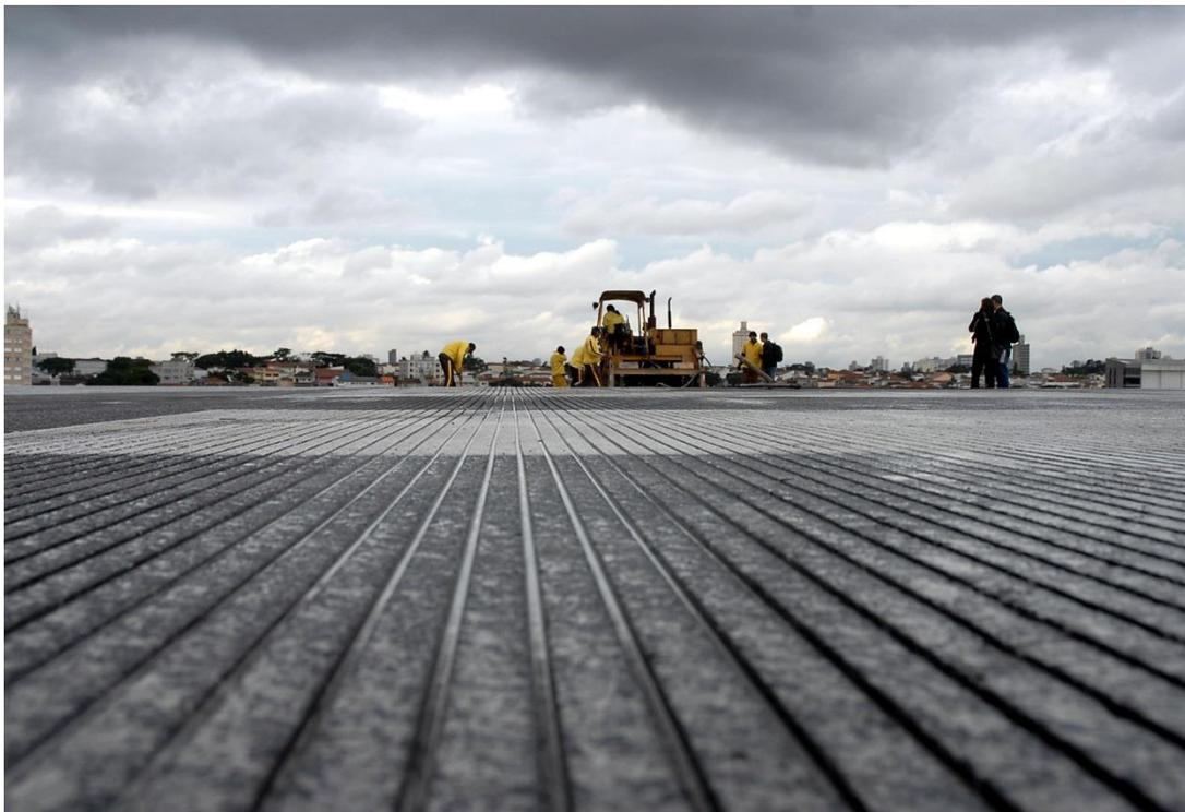
*Figura 32. Pista con ranurado transversal.*
