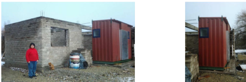
Figura 10: Vivienda rural en Sierra Colorada. Mampuesto de suelo/cemento y módulo sanitario prefabricado.
