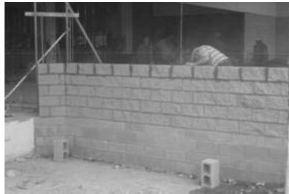
Figura 2 – Mampuesto de hormigón – Medio 1
