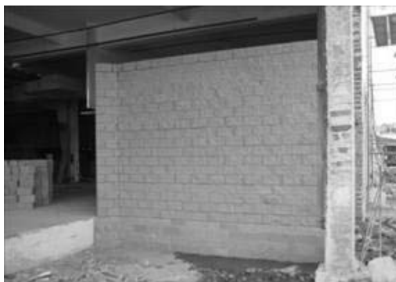
Figura 4 – Mampuesto de hormigón - Final
