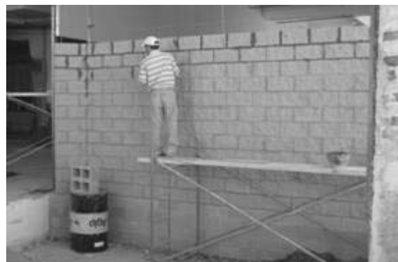
Figura 3 – Mampuesto de hormigón – Medio 2
