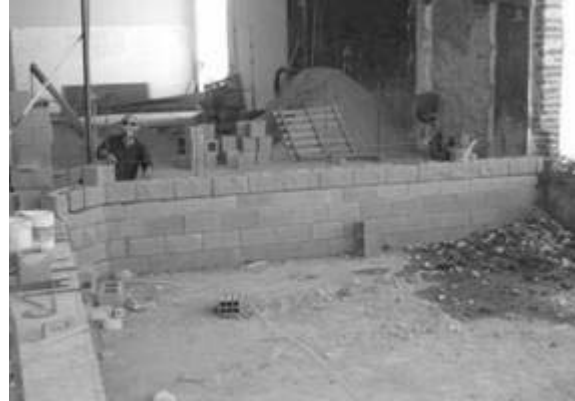
Figura 1 – Mampuesto de hormigón - Arranque
