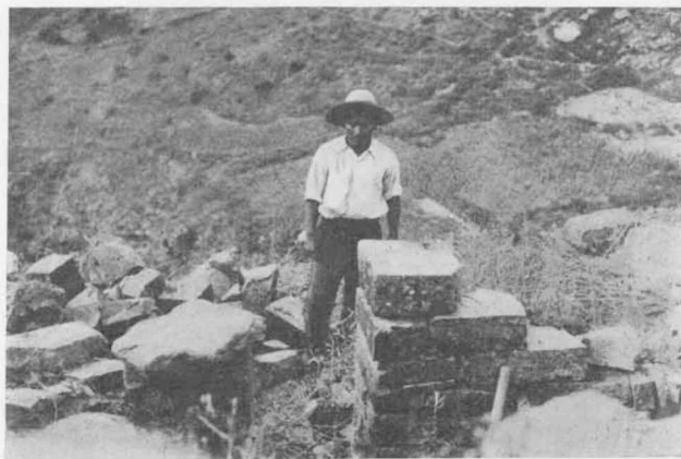
Fig. 5a. — a y b . Dos viviendas aborígenes en Huaira-Huasi, en donde se advierte, en la construcción de las puertas, el uso de grandes piedras canteadas
