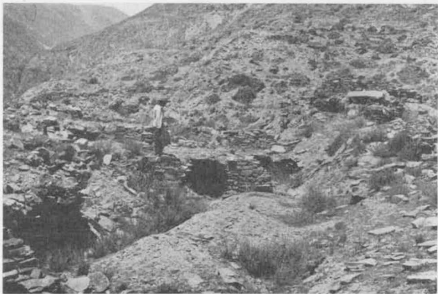
Fig. 9. — a y b , Construcciones en Titiconte, que presentan falsa bóveda, formada por hiladas superpuestas y techumbe de grandes lajas recubiertas de barro amasado con pequeños guijarros
