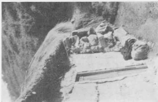
Fig. 46. — a y b, Dos detalles arquitectónicos de la vivienda rural en Careta Azul, tomados de la casa de Pastor Lanza, hecha de adobe con techo de paja
