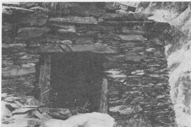
Fig. 62. — a , Casa autóctona, en Arcayo, compuesta de dos habitaciones comunicadas entre sí, con techos de piedra, en falsa bóveda; b , Puerta de comunicación entre ambas habitaciones, en la misma vivienda, encuadrada por grandes piedras.
