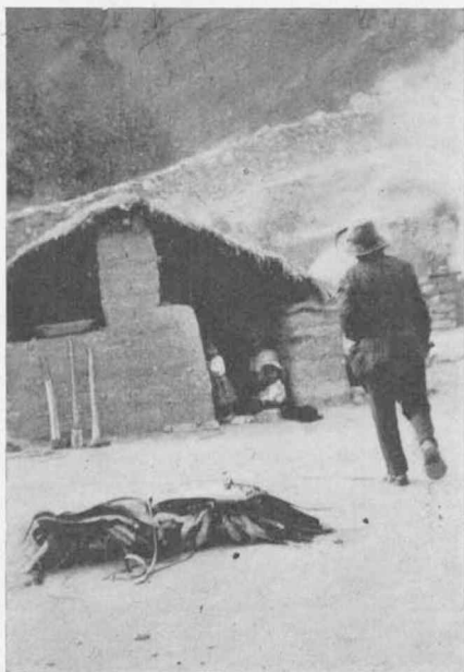
Fig. 31. — La cocina de la casa de Gutiérrez, lugar de reunión de la familia, constituida por una construcción asaz completa, de adobe, con muros laterales más altos y cerrados, y techo de paja recubierta de barro.
