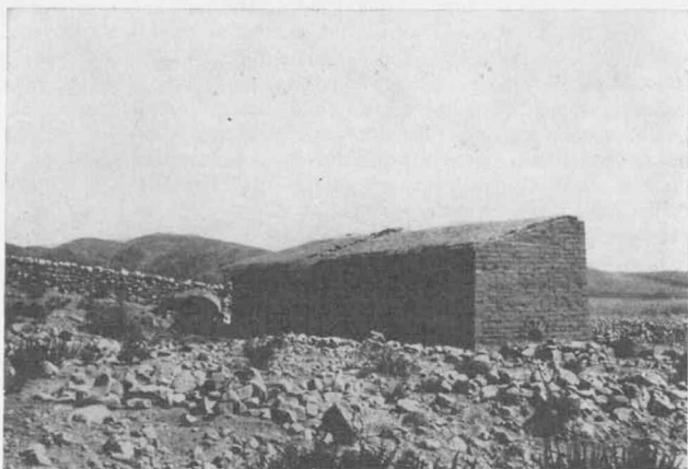
Fig. 45. — Casa en construcción en la que puede advertirse la forma de techar, poniendo sobre el envarillado una primera capa de paja y recubriéndola luego con barro amasado con pequeños gujarros
