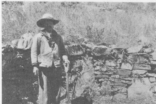
Fig. 50. — Detalle de la pared de una vivienda en Huaira-Huasi, en donde se advierte el uso conjunto de grandes bloques y de piedras menores, rigurosamente ensamblados, pese a su diferencia de tamaño
