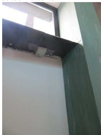
Figura 8. Colocación del sensor, visto desde abajo.
