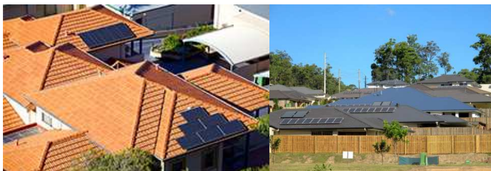
Figura 10: Instalaciones FV Australiana
